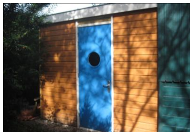
De vernieuwde aanbouw aan de achterkant van de sacristie (foto: Fred Houtenbos)
